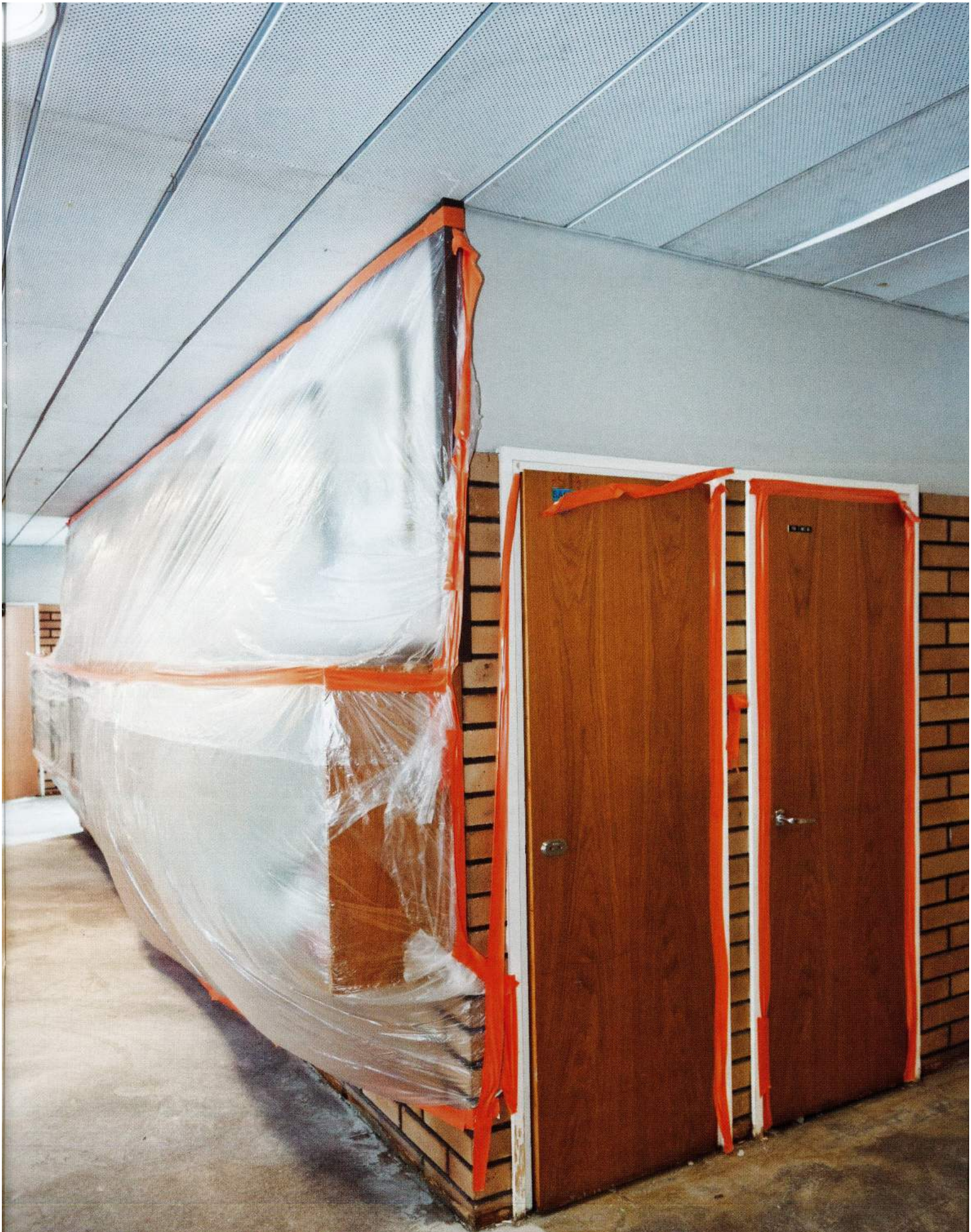
Remontin ulkopuolelle jäävä tila on eristetty muovien avulla. Kuva: YHA Kuvapankki / Pentti Hokkanen
