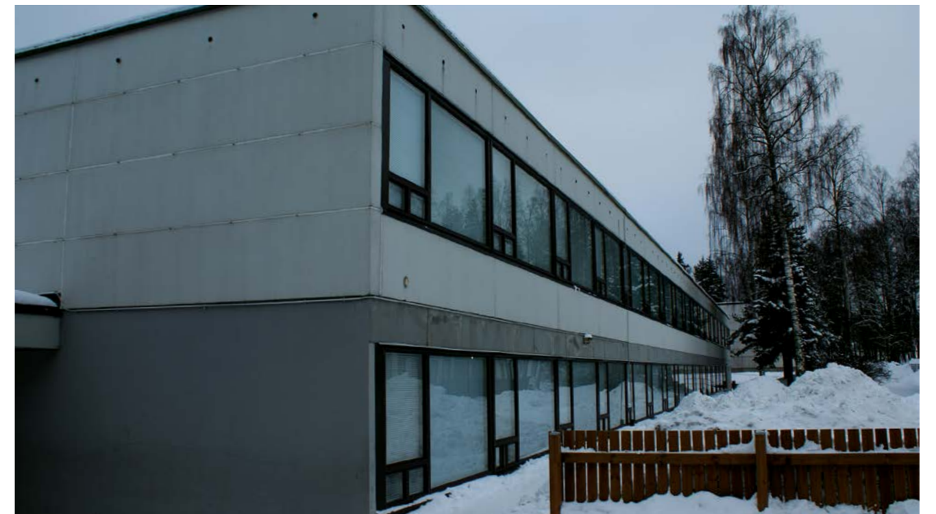
1970-luvulla rakennettu betoninen koulurakennus saa väistyä uuden tieltä 2020-luvulla. Osa opetuksesta tapahtuu jo uudisrakennuksissa.
